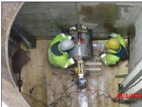
Bei der Horizontalfiltermontage im Senkschacht eines Horizontalfilterbrunnen in Hoyerswerda, Lachhammer, Paußnitz und Senftenberg für funnel & gate, Grundwasserniederhaltung und Trinkwasserfassung Foto: Dr. Thomas Daffner, UBV-Umweltbüro GmbH Vogtland, Berlin-Brandenburger Brunnentage 2016
